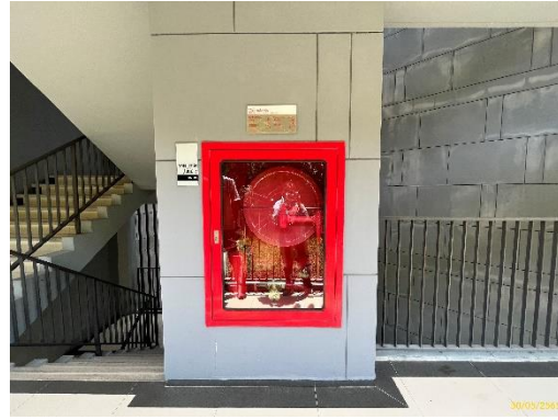
ตู้เก็บสายฉีดน้ำดับเพลิงพร้อมอุปกรณ์ (Fire Hose Cabinet : FHC)
