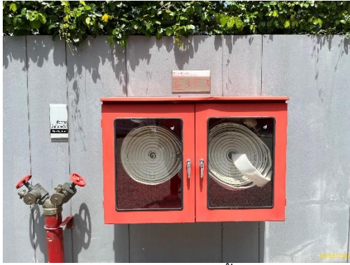
ตู้เก็บสายฉีดน้ำดับเพลิงพร้อมอุปกรณ์ (Fire Hose Cabinet : FHC)
